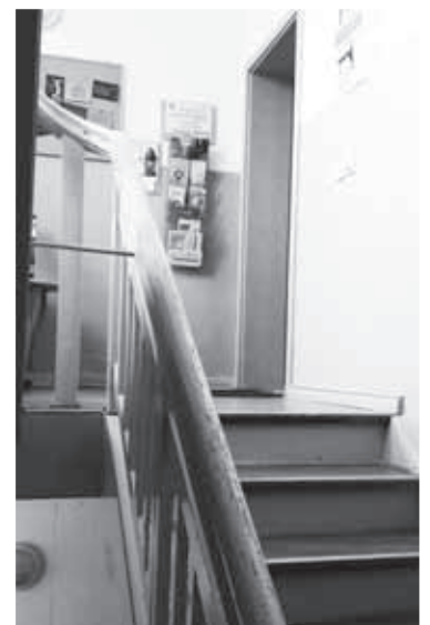
Der Aufgang zur Beratungsstelle in Bergen – nicht barrierefrei
